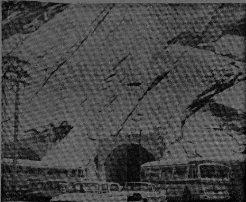
Vista exterior de la bóveda excavada en plena montaña, a unos 32 kilómetros de Salt Lake City. Al frente, una plaza de aparcamiento para automóviles.
